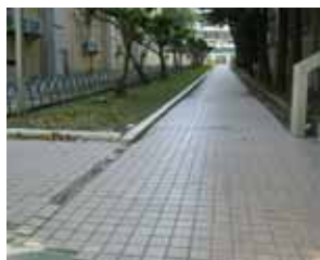
圖 16.磁磚雨天易滑、脫落未補
