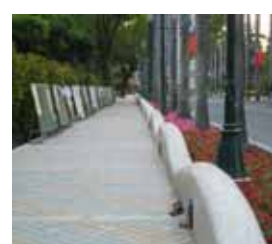
圖 13. 隱藏式路面照明燈
